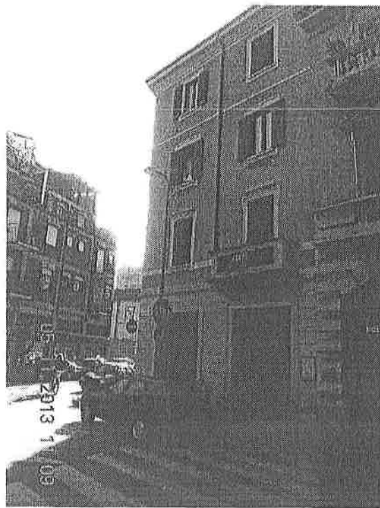
facciata angolo via Della Torre con via Rovetta
