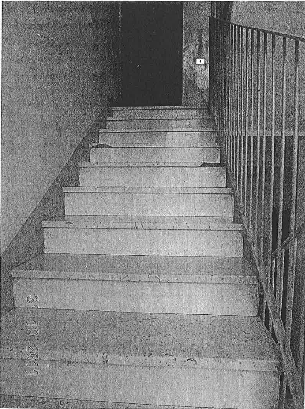
Vista di rampa della scala.
