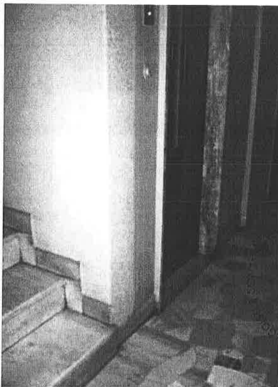
Foto n. 6 : pianerottolo vano scala ascensore
