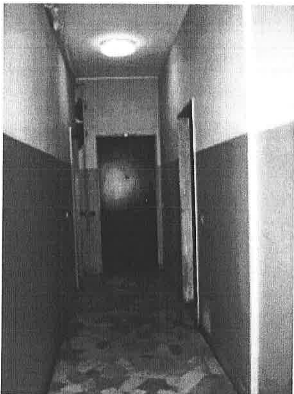
Foto n. 5 : pianerottolo porta ingresso appartamento Piano 1
