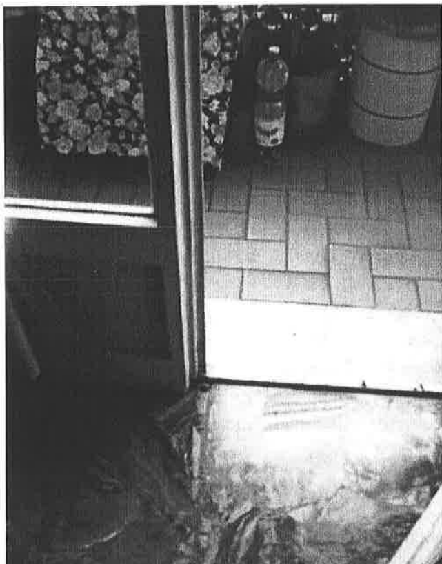
Foto n. 15 : particolare serramento soggiorno
